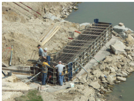
2. Die Bauarbeiten am Fundament Copyright: ArchIng - Kammer der Architekten und Ingenieurkonsulenten für OÖ und Sbg.
