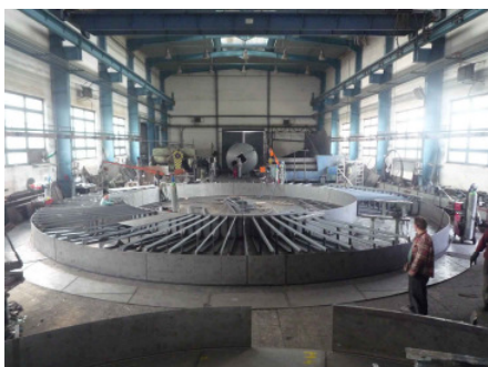
3. Konstruktion des Linzer Auges in der Werft in Bratislava Copyright: feld72
